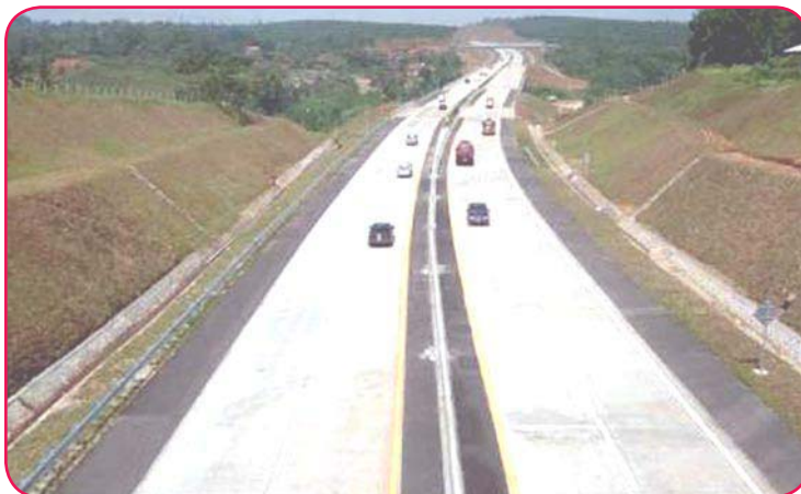
Gambar 2. 12 Membayar tarif tol merupakan salah satu sumber dana bagi pembangunan.
