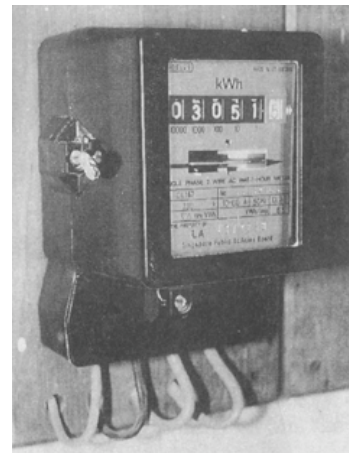
Gambar 6.20 kWh meter yang ada di rumah digunakan untuk mengukur daya listrik yang terpakai.
