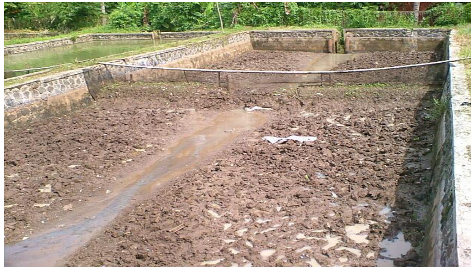
Gambar 23. Pengeringan kolam tanah
