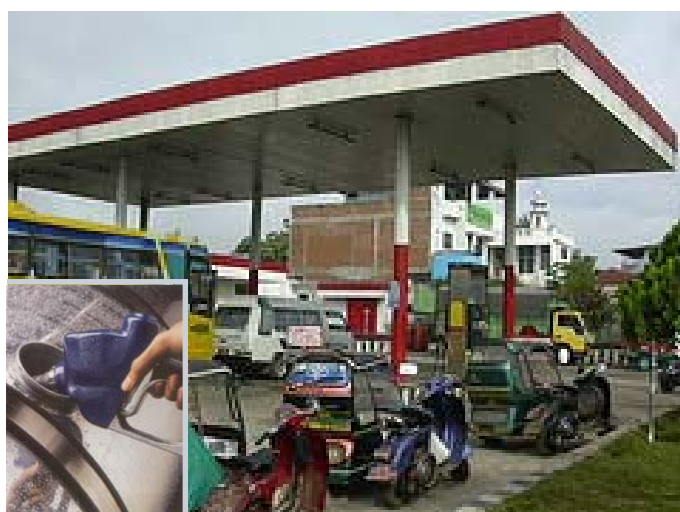
Gambar 4.3 Bensin merupakan zat kimia yang mudah terbakar. Oleh karena itu di SPBU selalu ada peringatan "DILARANG MEROKOK".
