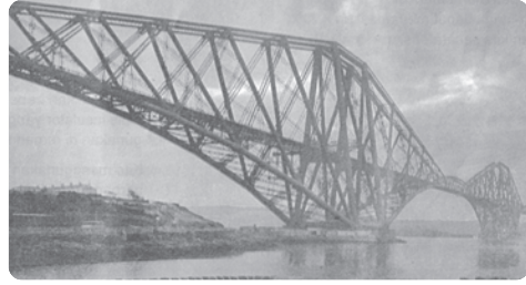
Gambar 8.1 Jembatan kereta di Skotlandia mengembang satu meter lebih panjang dari panjang semula pada musim panas.
