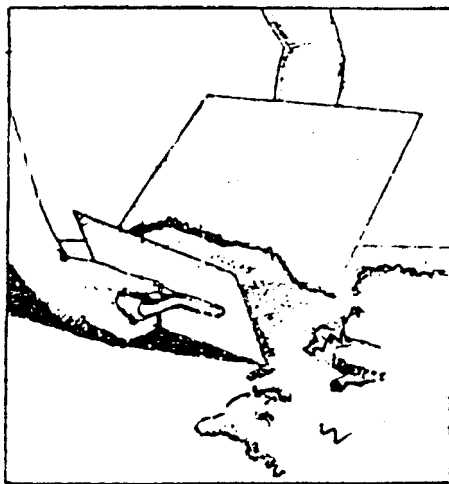
Gambar 3.6. Penempatan meja spesi terhadap dinding
