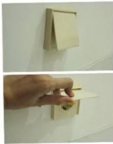
Gambar 21. Stop kontak khusus (safety)
