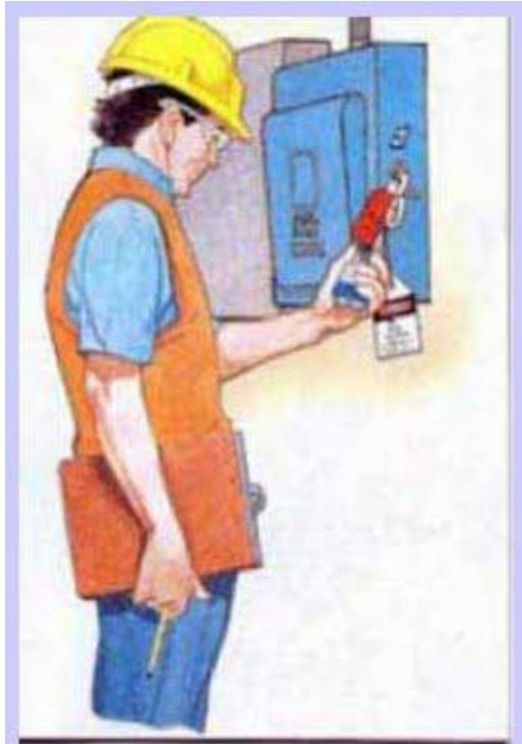
Gambar 1.24 Tanda pekerjaan selesai
