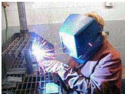
Gambar Pekerjaan Mengelas menggunakan las busur nyala listrik
