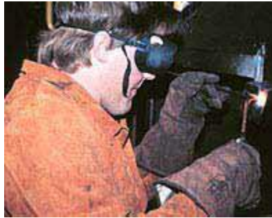
Gambar pekerjaan mengelas dengan oxy-acetylene
