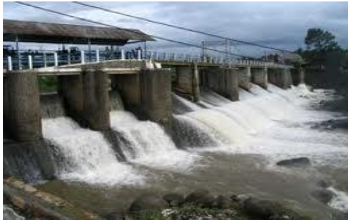
Gambar 16. Air waduk atau bendung
