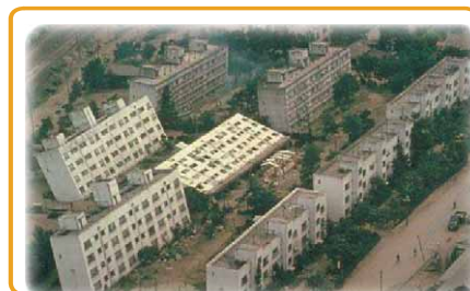
Gambar 1.10 Kerusakan akibat gempa Sumber: img118.imageshack.us
